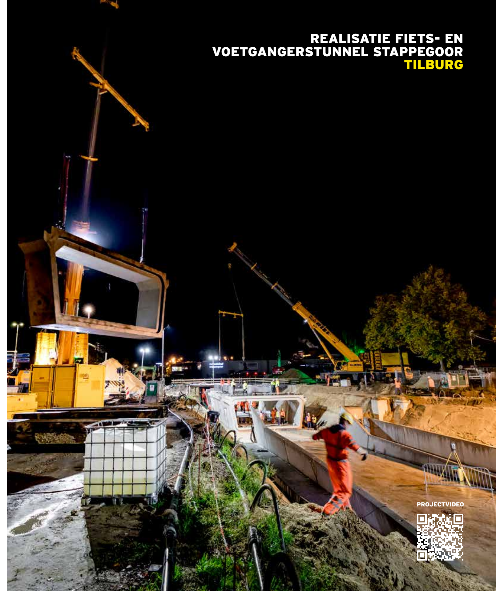
Oprachtgever Gemeente Tilburg Bijzonderheden Dura Vermeer heeft een van de eerste circulaire fiets- en voetgangerstunnels van Nederland gerealiseerd, die zorgt voor een betere doorstroming én veiligheid in Tilburg. De tunnel is in de toekomst weer te demonteren en op een andere locatie in te zetten.
