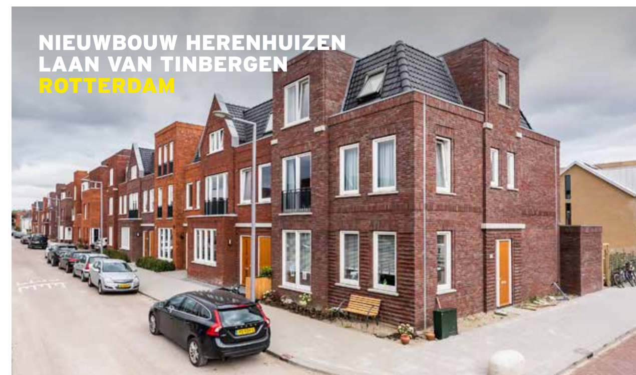
Opdrachtgever Dura Vermeer Bouw Zuid West Bijzonderheden Toekomstbestendige en gasloze woningen, waarbij iedere woning beschikt over een eigen warmtepomp en zonnepanelen. De EPC is hiermee lager dan 0,19.
