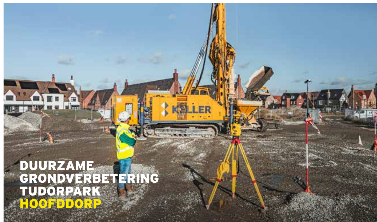
Oprachtgever VOF Tudorpark Bijzonderheden De grond van bouwfase Tudor Castle is bouwklaar gemaakt met een bijzonder systeem, genaamd 'rüttelstopverdichting'. Dit systeem is volledig circulair en de CO 2 -footprint is zeer laag. Het is voor het eerst dat in Nederland deze manier van grondverbetering wordt toegepast bij woningbouw.
